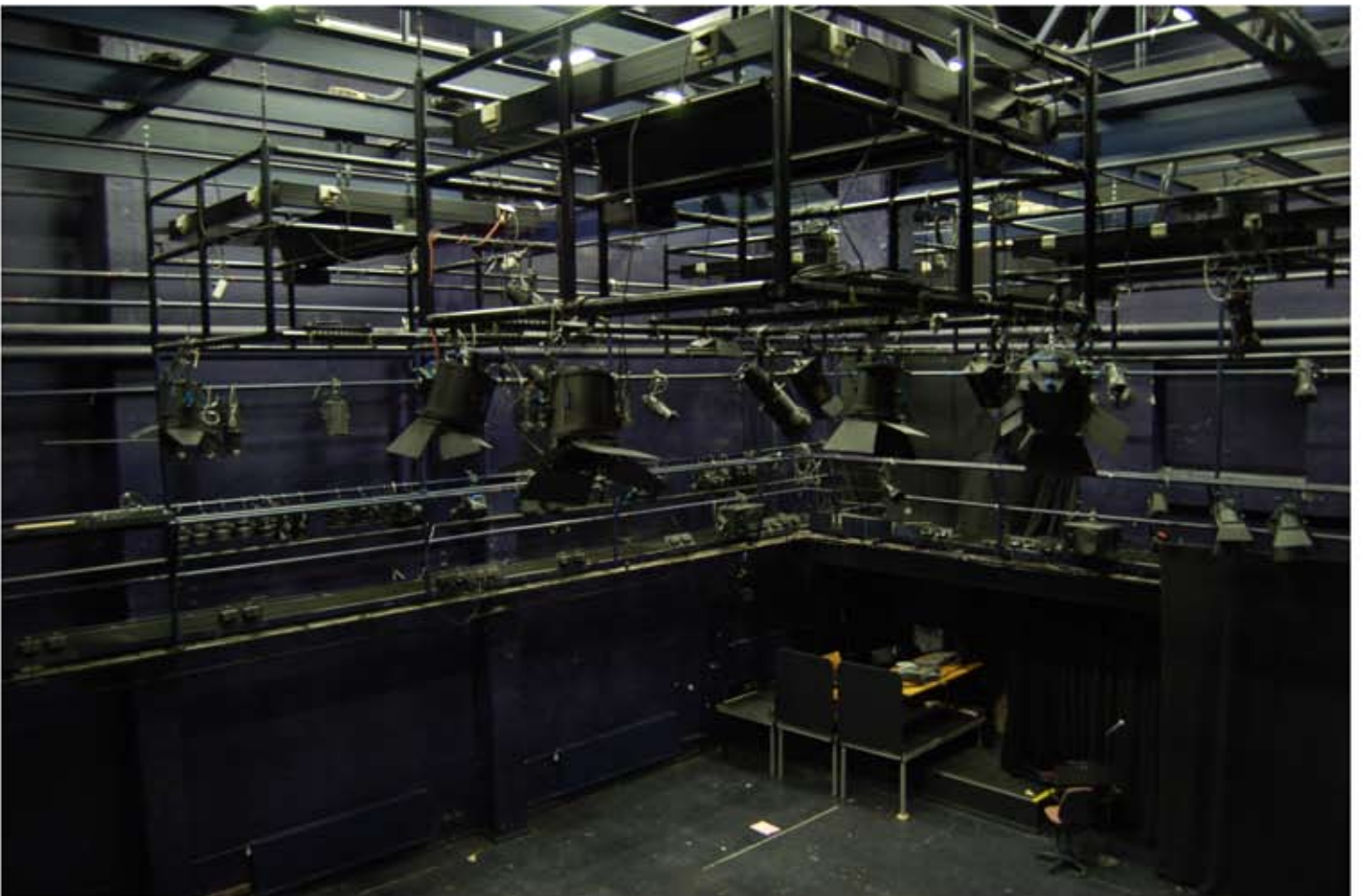
Kuva 4: Teatteri Verstas 2. kerroksesta kuvattuna.
